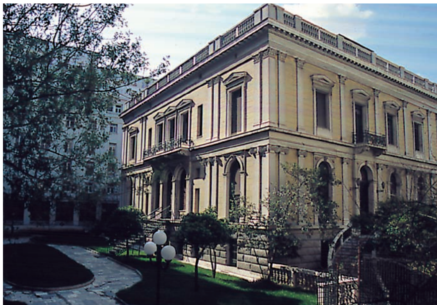
Το ιστορικό κτήριο της οδού Πανεπιστημίου, από τα αξιολογότερα έργα του Γερμανού αρχιτέκτονα Ερνέστου Σσίλερ. Κτίστηκε το διάστημα 1878-1879 ως κατοικία της οικογένειας Σλήμαν. Εδώ, η πίσω όψη του κτηρίου
